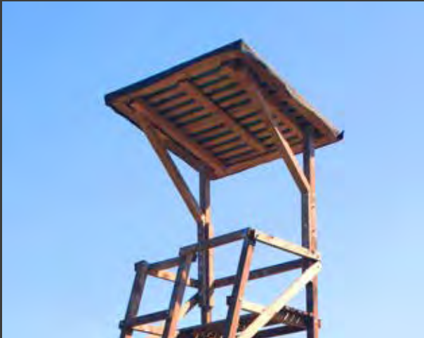
Dachkonstruktion 140 x 140 cm mit nur zwei Pfosten zum Mitschwingen
