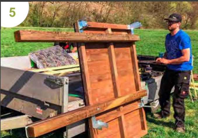
5 Die Montagehülsen und die Holme für das Gitterrostpodest unter den Boden schrauben. Abdeckbleche auf den Holmen nicht vergessen.
