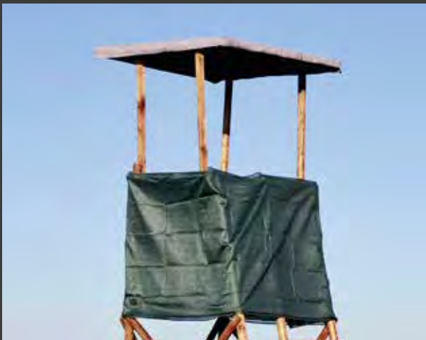
Dachkonstruktion 140 x 140 cm mit vier Pfosten und Tarnnetz - hat den Vorteil des Anstreichens bei stehendem Wild auf große Entfernung
