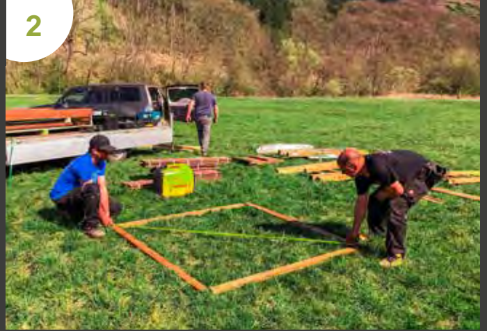
2 Die unteren Querholme zum Quadrat auf den Boden legen und durch gleiche Diagonalen die Rechtwinkligkeit herstellen.
