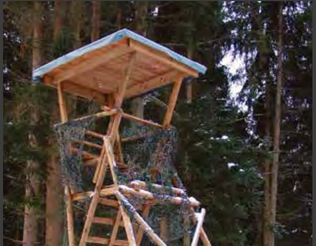
Dachkonstruktion 180 x 180 cm
