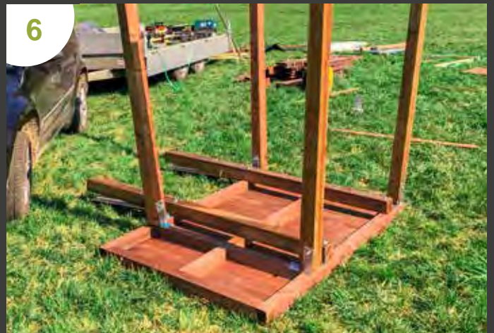
6 Die 4 Holme vom Unterbau unter dem Boden in den Montagehülsen festschrauben.
