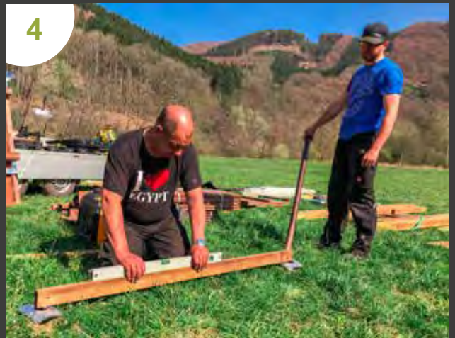
4 Die Erdankerschrauben werden auf gleiche Höhe gebracht. Bei Schräghanglage werden die Holme entsprechend der Höhenunterschiede abgeschnitten. Siehe auch Seite 51.
